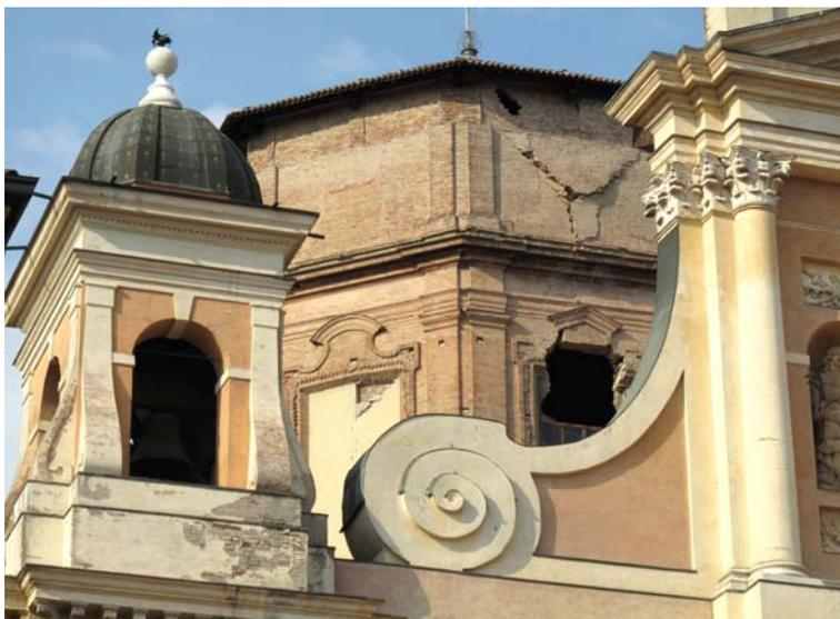
Le navate laterali presentano una serie di lesioni da distacco dovute al movimento est-ovest del fabbricato, che si sono verificate in corrispondenza dell'arco di collegamento tra le volte della navata centrale e quelle laterali.
