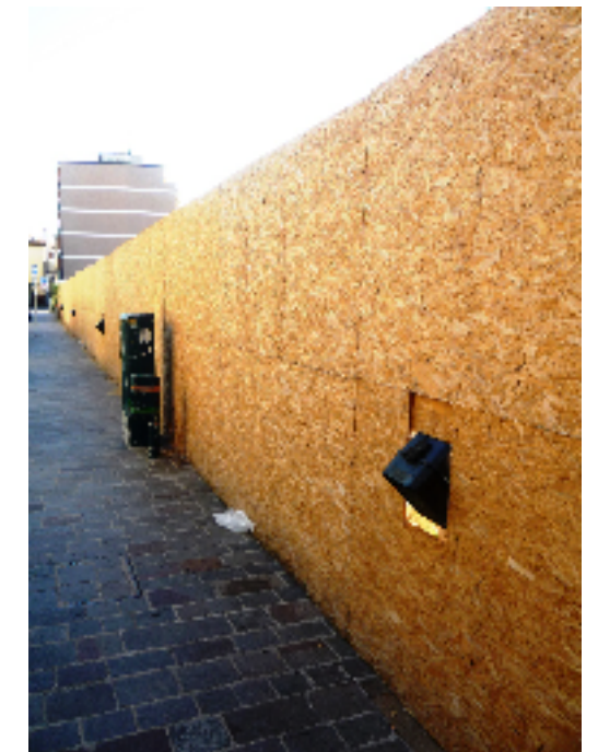
Recinzione con pannelli OSB/3 fissati a struttura in abete fissata a terra e controventata H. 200 cm.
