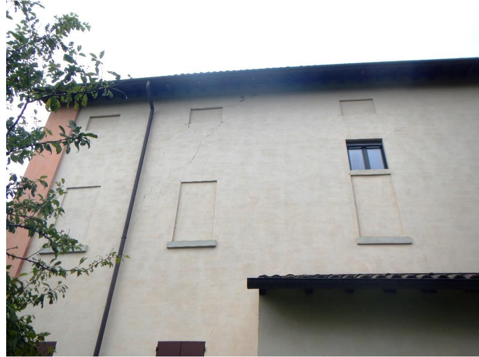
Prospetto Est oggi, presenti tracce delle finestre precedenti
