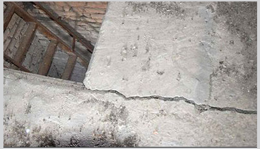
SULLA SINISTRA ESEMPIO DI LESIONE SUB-VERTICALE DOVUTA A TAGLIO E SOPRA LE LESIONI SU UN SOLAIO DEL CAMPANILE CAUSATE DALL'EVENTO SISMICO DEL 2012
