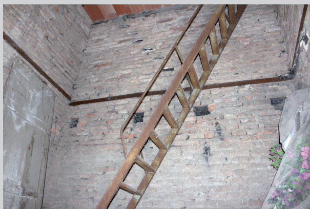
ELEMENTI METALLICI INSERITI NELLA MURATURA IN CORRISPONDENZA DI ANTICHI SOLAI (FOTO PRECEDEN- TI IL RESTAURO)
