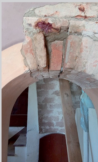
RIPRISTINO DELLA CONTINUITÀ DELLA MURATURA; RINFORZO E CONSOLIDAMENTO DELL'ARCO DELLA MURATURA
