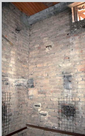
A SINISTRA I SEGNI DEGLI ALLOGGIAMENTI DELLE ANTICHE TRAVI LIGNEE E A DESTRA S I SEGNI DELL'ANTICO CORPO SCALA
