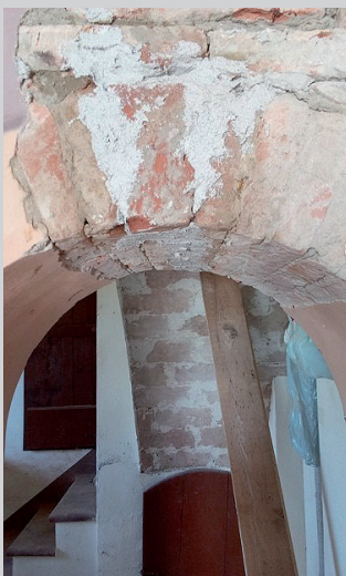
RIPRISTINO DELLA CONTINUITÀ DELLA MURATURA; RINFORZO E CONSOLIDAMENTO DELL'ARCO DELLA MURATURA
