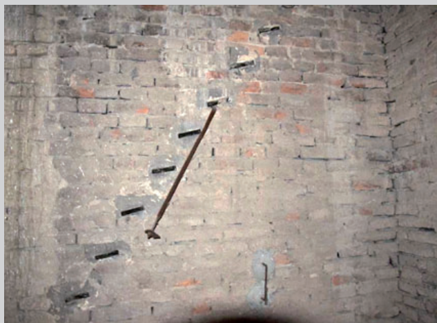
A SINISTRA I SEGNI DEGLI ALLOGGIAMENTI DELLE ANTICHE TRAVI LIGNEE E A DESTRA S I SEGNI DELL'ANTICO CORPO SCALA
