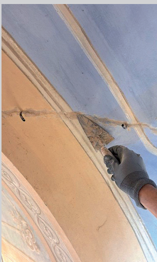
RIPRISTINO MATERICO DELLA VOLTA A VELA MEDIANTE INIEZIONI DI MALTA, RIPRISTINO DEGLI INTONACI E DEI DECORI ESISTENTI
