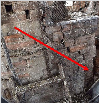
SULLA SINISTRA ESEMPIO DI LESIONE DOVUTA A TAGLIO CON DISLOCA- MENTO DEI LATERIZI E SULLA DESTRA LE LESIONI DOVUTE A SCHIACCIA- MENTO CHE CARATTERIZZANO I PILASTRINI DELLA CELLA CAMPANARIA
