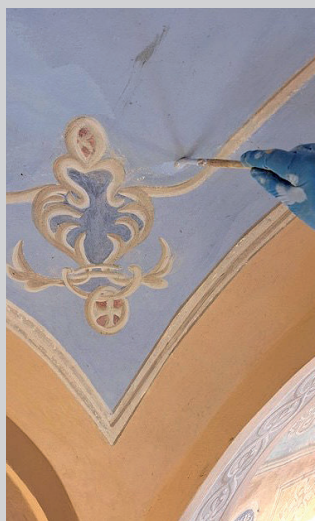
RIPRISTINO MATERICO DELLA VOLTA A VELA MEDIANTE INIEZIONI DI MALTA, RIPRISTINO DEGLI INTONACI E DEI DECORI ESISTENTI
