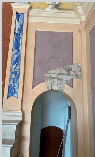
RIPRISTINO DELLA CONTINUITÀ DELLA MURATURA; RINFORZO E CONSOLIDAMENTO DELL'ARCO DELLA MURATURA
