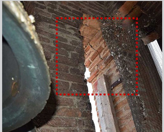
SULLA SINISTRA ESEMPIO DI LESIONE DOVUTA A TAGLIO CON DISLOCA- MENTO DEI LATERIZI E SULLA DESTRA LE LESIONI DOVUTE A SCHIACCIA- MENTO CHE CARATTERIZZANO I PILASTRINI DELLA CELLA CAMPANARIA
