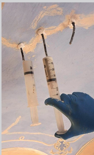
RIPRISTINO MATERICO DELLA VOLTA A VELA MEDIANTE INIEZIONI DI MALTA, RIPRISTINO DEGLI INTONACI E DEI DECORI ESISTENTI
